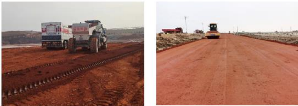
赤泥回填筑路基
